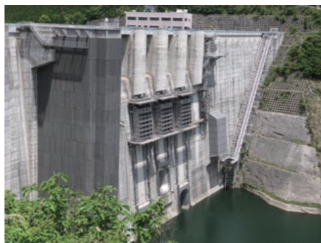
水库进水塔、高压闸门 (SUS304、NSSC2120、NSSC2304)
